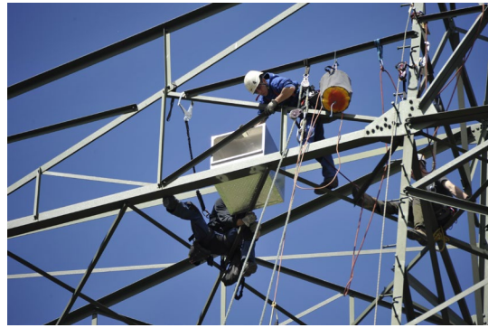
Abbildung C.2 Montage eines Brutkastens
