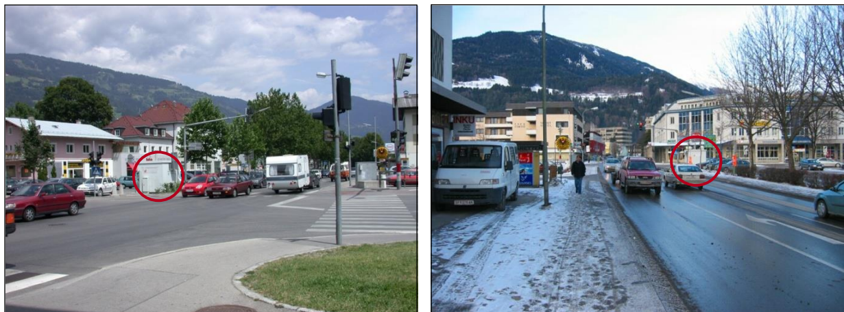
Abbildung 9: Messstelle Lienz Amlacher Kreuzung, Ansicht von Südwesten (links), Ansicht von Osten entlang Tiroler Straße (rechts). (© Amt der Tiroler Landesregierung).
